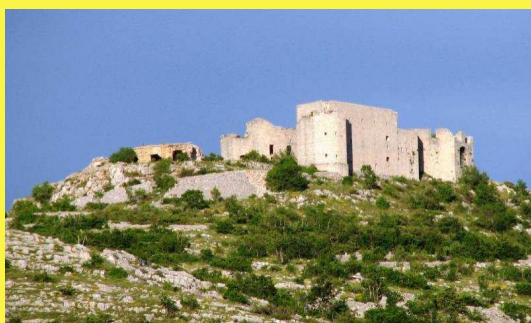
Werk VII Golo Brdo - Kehle und recht Flanke aus westlicher Richtung gorge and right flank seen from the west
